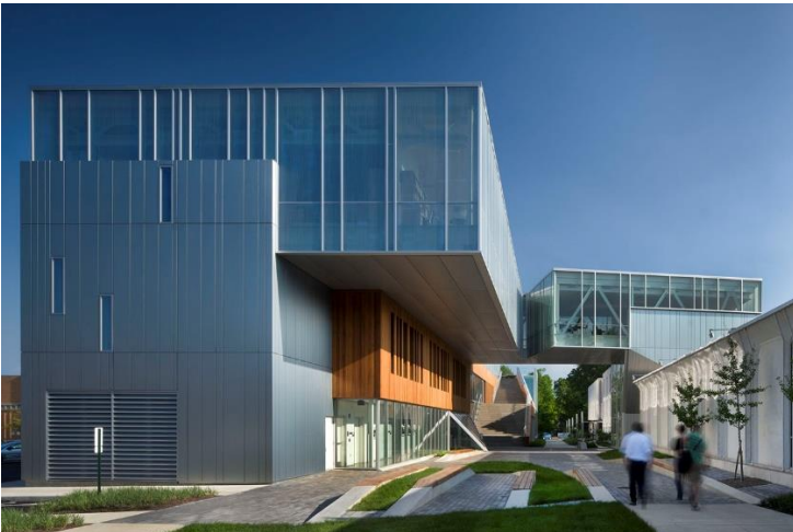
Şekil 13. Bertram ve Judith Kohl Binası genel görünüm
