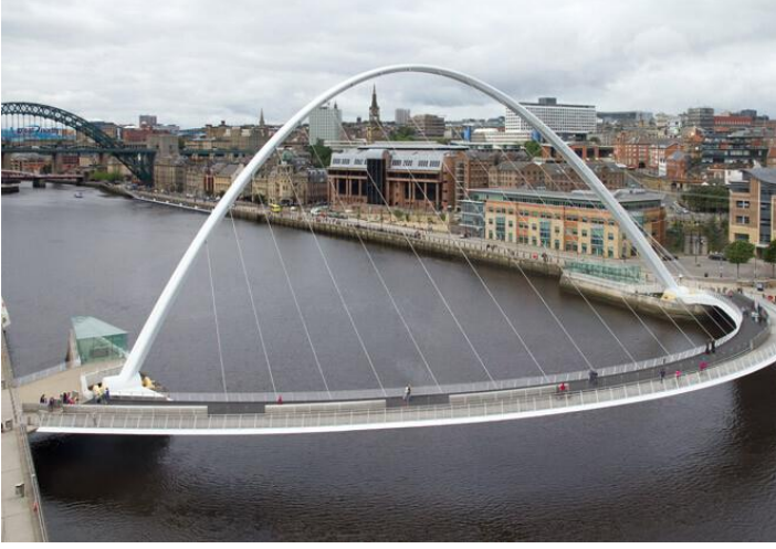
Şekil 3. Gateshead Milenyum Köprüsü'nün genel görünüm
