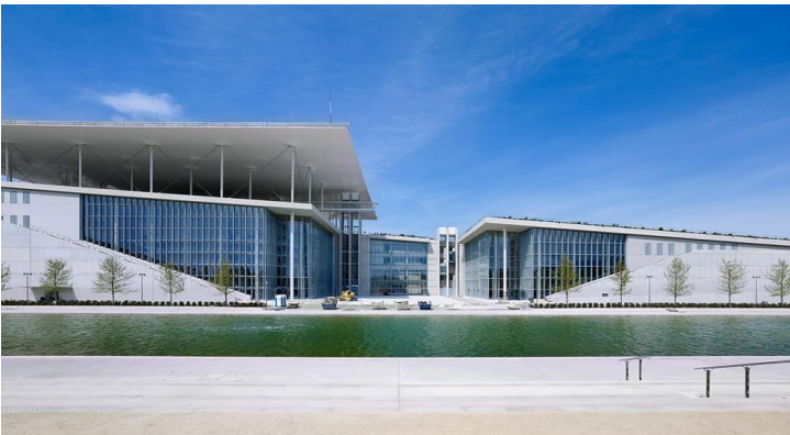
Şekil 5. Stavros Niarchos Kültür Merkezi genel görünüm
