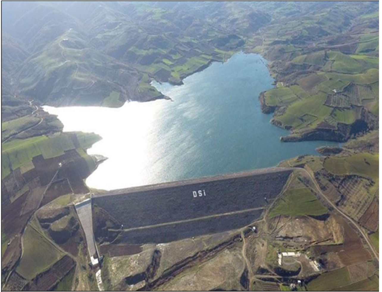
Şekil 2: Naip Barajının havadan görünümü (Süleymanpaşa Belediyesi, 2021) / Figure 2: Aerial view of Naip Dam (Suleymanpasa Belediyesi, 2021)
