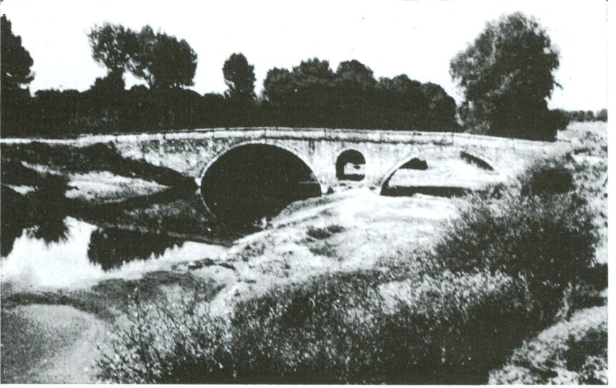
Res. 8 — Filibe yakınında eski bir Türk köprüsü (Foto, S. Eyice, 1964).
