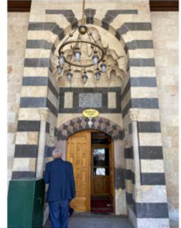
Bostancı Camii Taç Kapısı
