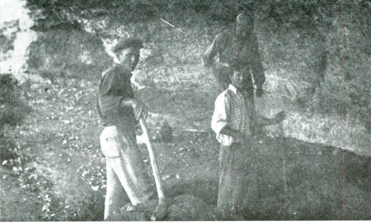
Res. 50 — Kaya sığınaklarında çalışmalar. 1960
