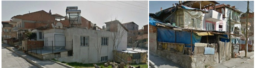
Şekil 11: Karşıyaka Mahallesi güvenlik riski taşıyan konut bölgesi (Kişisel Arşiv, 2020).
