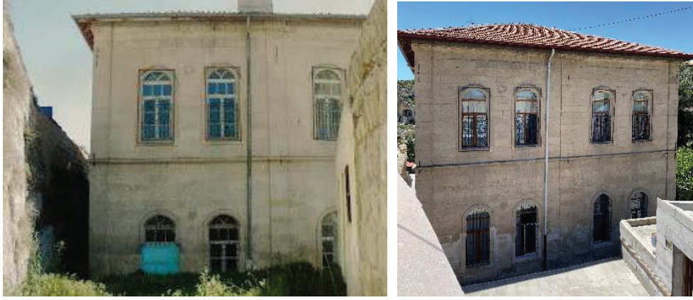
Görsel 17. Yapının Doğu Cephesinde Sonradan Kapıya Çevrilen Pencere ve Restorasyon Sonrası Özgün Durumu.
