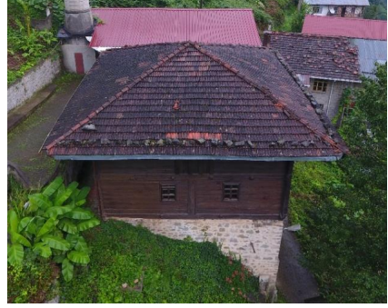
Foto. 4: Caminin Güney Cephesi
