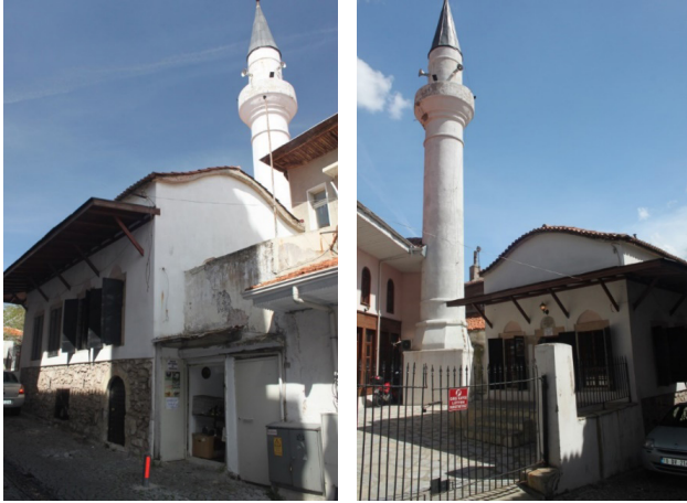
Fotoğraf 6: (sol) Güneybatı Cephesi, (sağ) Kuzeybatı Cephesi (Fotoğraf M. E. DERE)
