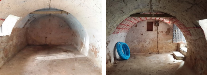
Fotoğraf 5: Bodrum Kat (sol) Kuzeye Bakış, (sağ) Güneye Bakış (Fotoğraf M. E. DERE)
