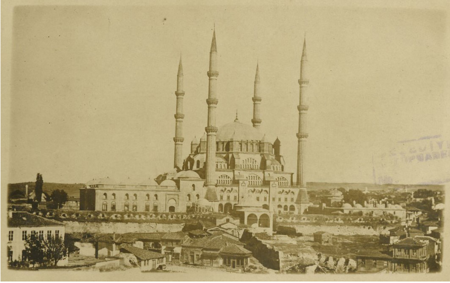
Resim 3: Selimiye Camii'nin batısındaki dükkân kalıntıları 56
