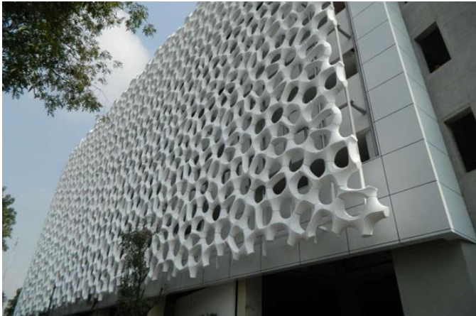
Şekil-7. Manuel Gea Gonzalez Hastanesi Cephesi (URL-7).
