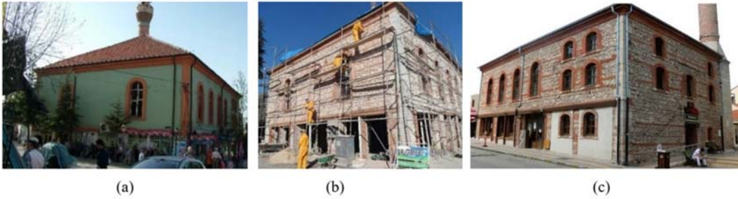
Şekil 1. Caminin 2013 yılı restorasyonuna ait görseller [25]: (a) Raspa öncesi, (b) Süreç görüntüsü, (c) Raspa sonrası (Images of the 2013 restoration of the mosque: (a) Before scraping, (b) Scraping process, (c) After scraping)
