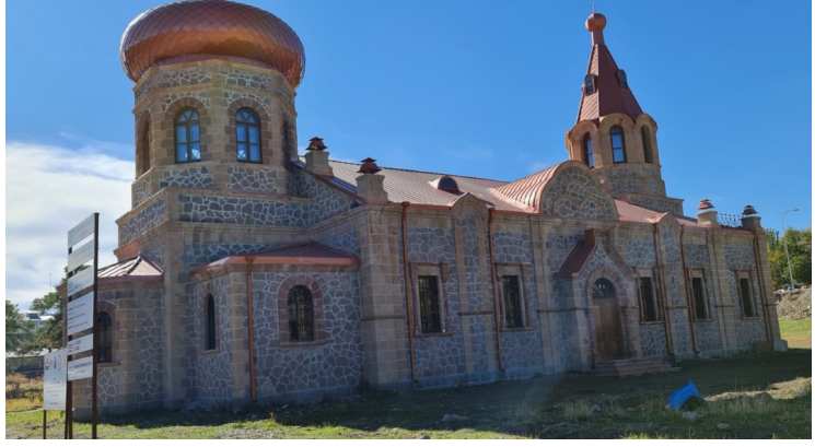
Görsel 23: Kilisenin Restorasyon Sonrası Görünüşü
