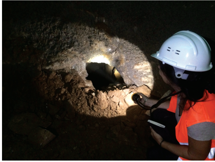
Şekil 2. Karaçat üretim galerisinde belirlenen düşey yönde gelişmiş düden Figure 2. Sinkhole developed vertically in the production gallery
