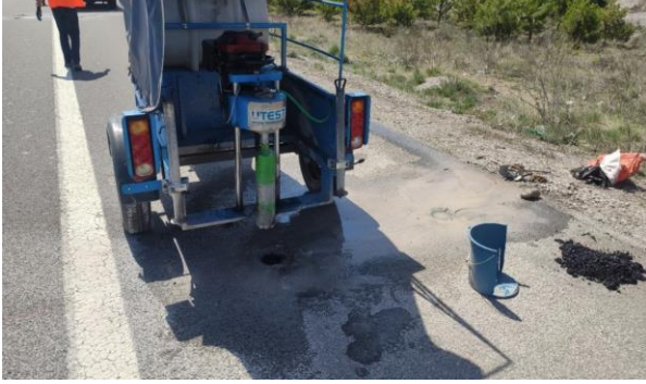
Şekil 10. Karot Çalışmaları
