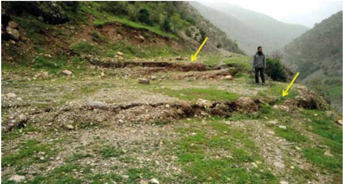
Şekil 18. Gökçekoru Köyü kuzeybatısında, sol sahilde re-aktivite geçirmiş heyelan ve buna bağlı gelişen kırıklar yakın geçmişte yapılan yolu iki yerden etkilemiştir. Lokasyon için Şekil 16'ya bakınız.
