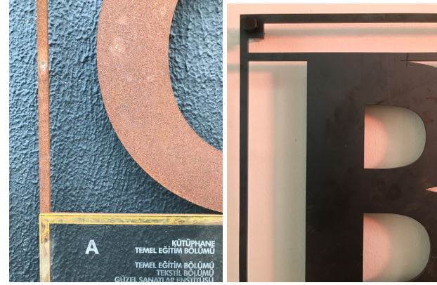
Resim 10. Kullanılan saç malzemenin zamanla paslanması öngörülmüş-tür. (Görsel kaynak: Yazarın kendi çektiği fotoğraf.)
