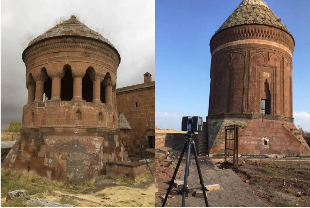
Foto 7: Emir Bayındır ve Erzen Hatun kümbetlerinde 3Boyutlu Yersel Lazer tarayıcı cihazı ile ölçüm
