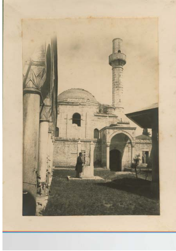
Foto. 5: Bugün, üzerinde çok katlı muhalebici dükkanı bulunan binanın yerinde; Kaptan Halil Paşa Camii yer almaktaydı. Camii, 1930'lu yılların başlarında kadro dışı bırakılarak satılmıştır. (Süleyman Faruk Göncüoğlu Arşivi)
