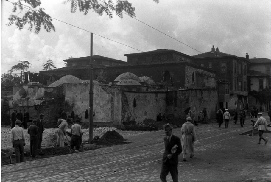
Foto. 7 (1): Çandarlı İbrahim Paşa Hamamı, yeni açılmakta olan Atatürk Bulvarı'nın ikinci etabı üzerine denk geldiğinden önce küllhanlık kısmı, daha sonra da hamamın tamamı yıktırılmıştır. (Süleyman Faruk Göncüoğlu Arşivi)
