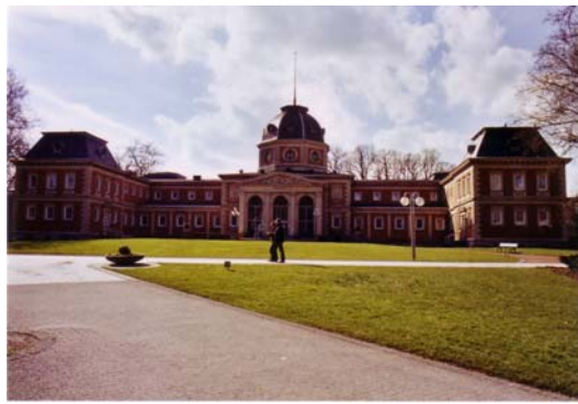
Foto 2: Bad Oeynhausen- IV Nolu Kaplıca Binası (M.Yavuz)
