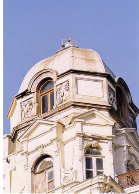
Foto 8: Rumeli Hanı, Köşe Kubbesi (M.Yavuz)
