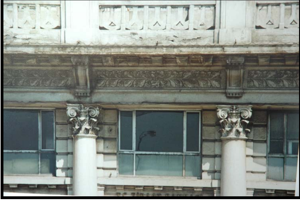
Foto 5 : Ziraat Bankası Karaköy Şubesi Hizmet Binası Giriş Cephesinden Ayrıntı.
