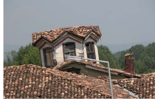
Resim 36. Evin cihannüma katı ve çatı kaplaması
