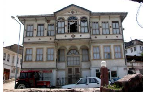
Resim 26. Çakıroğlu Konağı doğu cephesi
