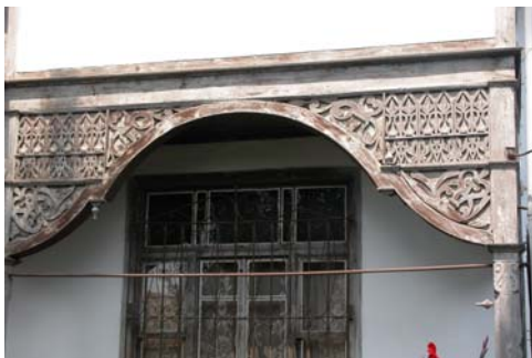
Resim 16. Dođu cephesi revađında yer alan ahşap süslemeler
