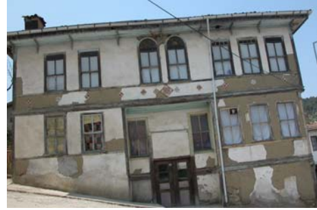
Resim 27. Evin Güney cephesi
