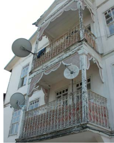
Resim 23. Evin doğu cephesinde yer alan 1. ve 2. kat balkonları
