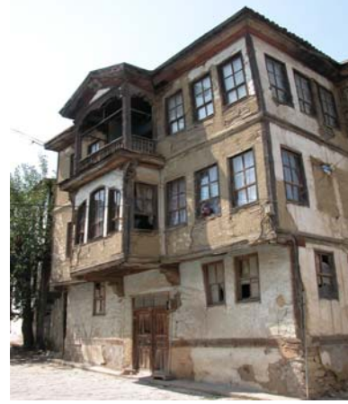
Resim 33. Fenerli Ev'in güney cepheden görünümü
