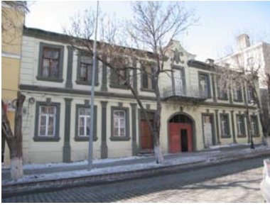
Foto.57- Caddeye bakan cephesiyle bir sivil mimarlık örneği
