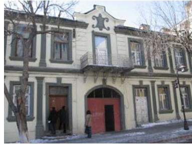
Foto.58- Cephe ortası ve giriş
