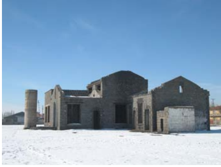
Foto.9- İstasyon Revizörlük Binası
