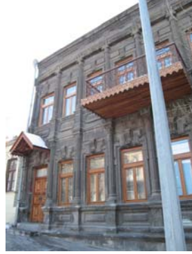
Foto.52- Giriş cephesi ile bir konut
