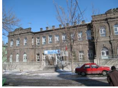
Foto.50- İlköğretim Okulu'nun yandan görünüşü
