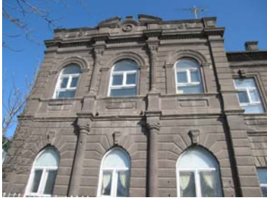
Foto.51- Okulun cephesinden ayrıntı
