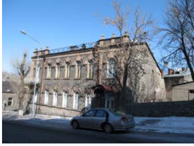
Foto.45- Eski Rus Konsolosluğu Binası
