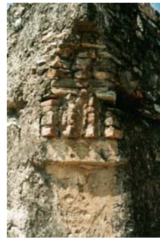
Resim 24- Merkez, Kemer Namazgâhi pah uygulaması
