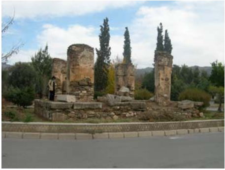
Resim 11- Merkez, Kemer Namazgâhı (onarım öncesi)
