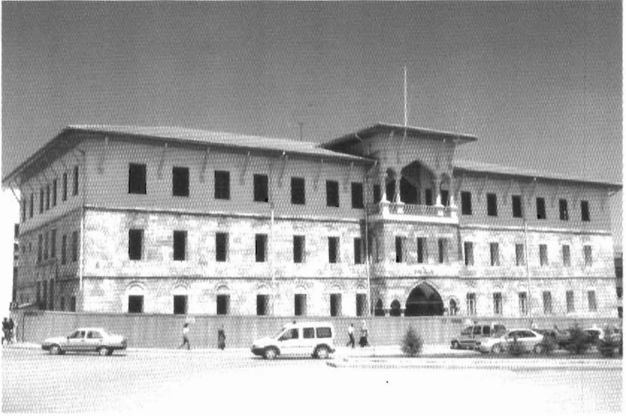
Foto.: 11-Sivas Valilik Binası
