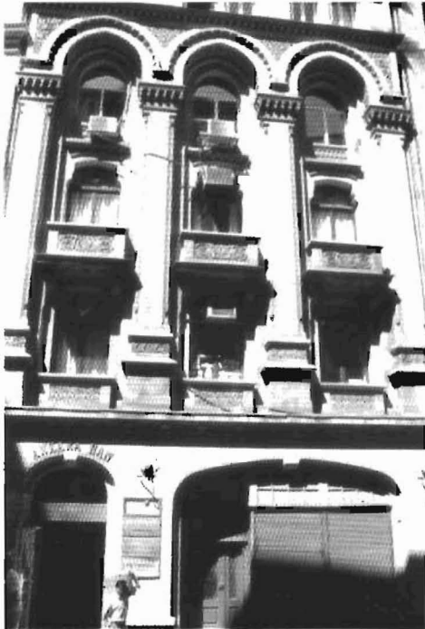
Foto.: 3-Ankara Han Güney Cepheden Görünüm
