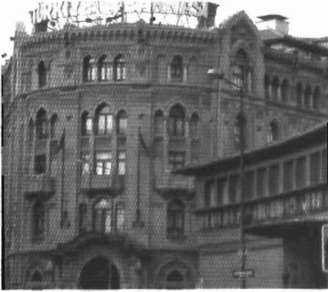
Foto.: 9-Ankara-Türkiye İş Bankası Merkez Binası
