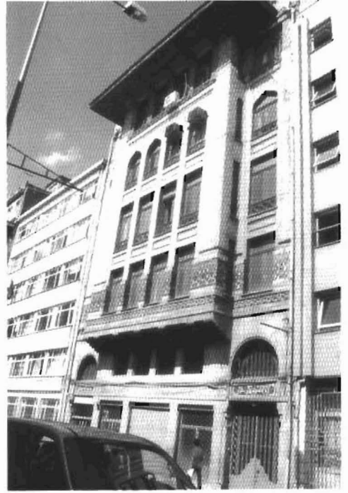
Foto.: 6-Söğütözü Denizcilik Han Güney Cepheden
