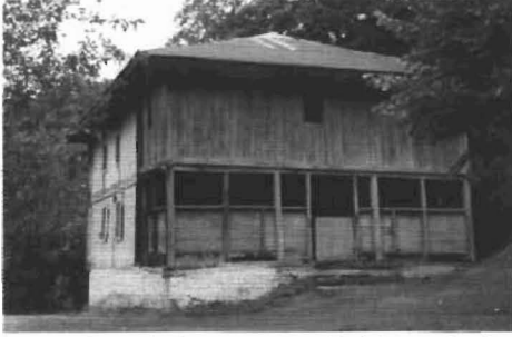
Foto.: 3- Perşembe Soğukpınar Köyü Hatıpli Mah. Camii
