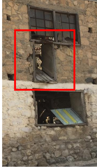
Resim 18. Hüseyin Baş Değirmeni doğu cephesi öğütülen tahılların dışarı aktarıldığı bir bölme (Gökarslan ve Köse arşivi, 2022)
