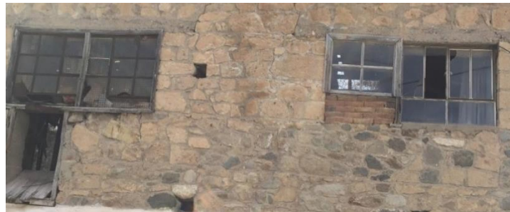
Resim 17. Hüseyin Baş Değirmeni doğu cephesi özgün ve muhdes ahşap pencere doğramaları (Gökarslan ve Köse arşivi, 2022)
