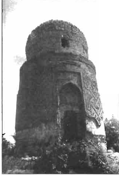
Resim 10: Zeynel Bey Türbesi, Güney Cepheden Genel Görünüş
