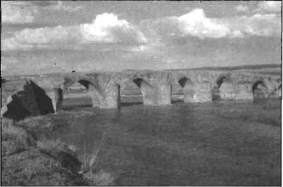
Resim -2 Çobandede Köprüsünden Bir Görünüm
