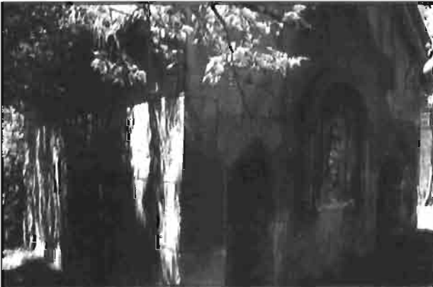
Resim 3: Vaftiz binasının güneydoğu cephesi.
