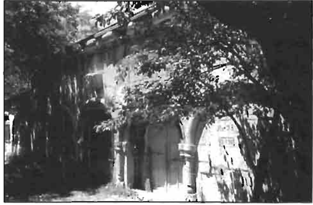
Resim 8: Haho Kilisesi güneyinde bulunan revakın görünüşü.
