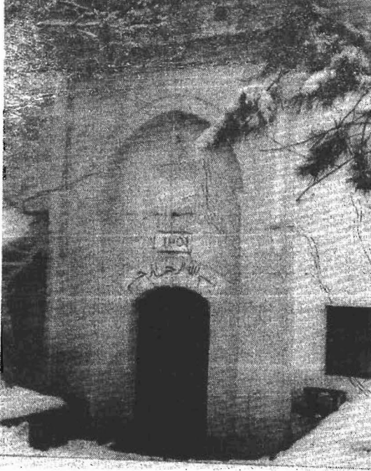
Resim4- Yukarı Dikmen Köyü Camii Giriş Cephesi
