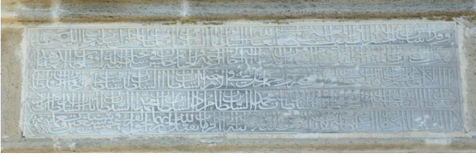
Fot. 5: Silivri yönündeki dördüncü köprü memba yönündeki kitabeliğindeki Arapça Kitabe.
