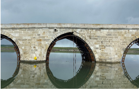
Fot. 10: Büyükçekmece Köprüsü Silivri yönündeki dördüncü köprüsünün sonan dördüncü kemeri mansap görünüşü.
