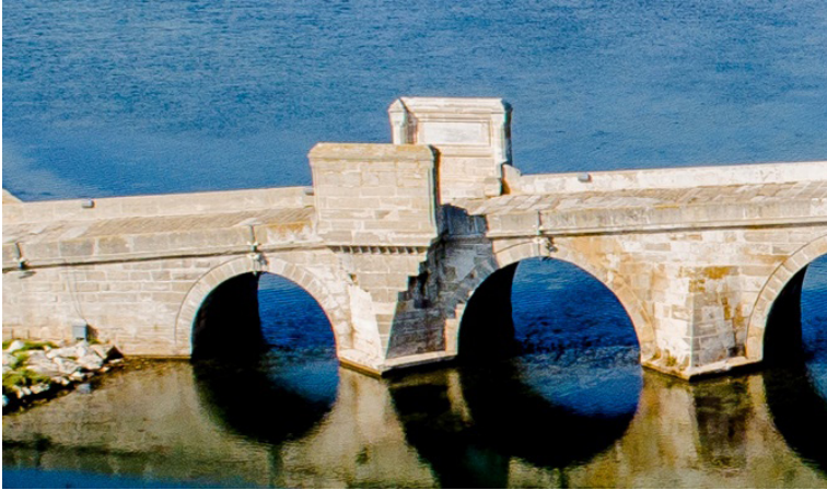
Fot. 4: Köprü mansap cephesi, Silivri yönündeki dördüncü köprü, kitabelikler.
