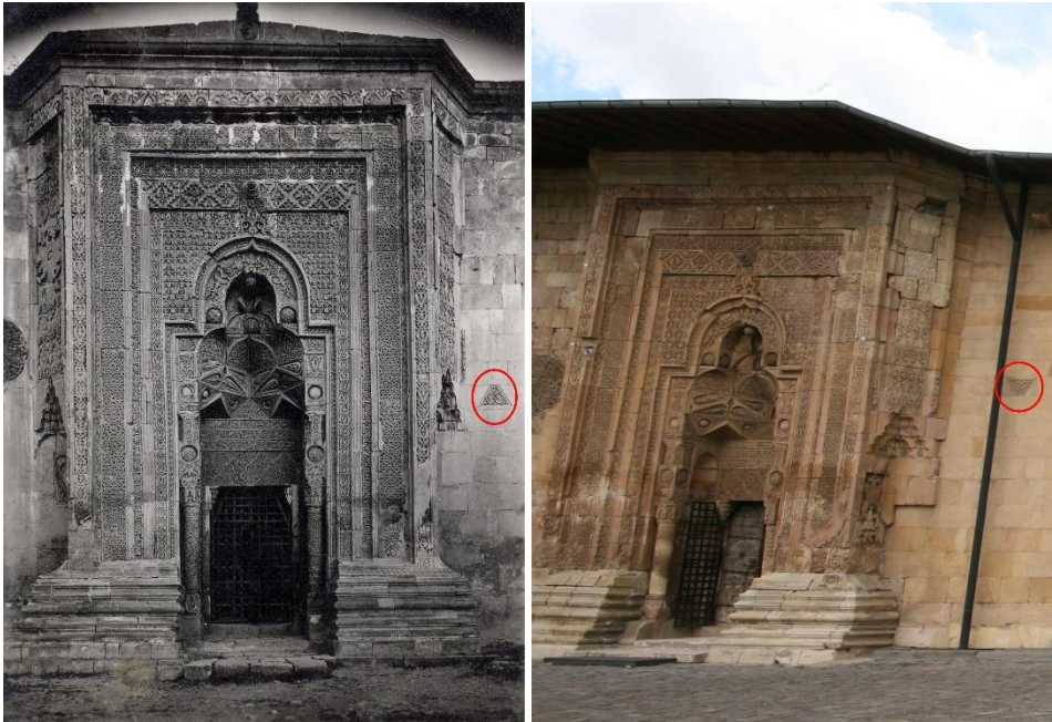
Görsel 18. Divriği Ulu Camisi Batı Taçkapısının Yanındaki Onarımlarda Konumu Değiştirilmiş Pano A-20. Yüzyılın Başındaki Durumu (A. S. Ülgen'den) B-Günümüzdeki Durumu
