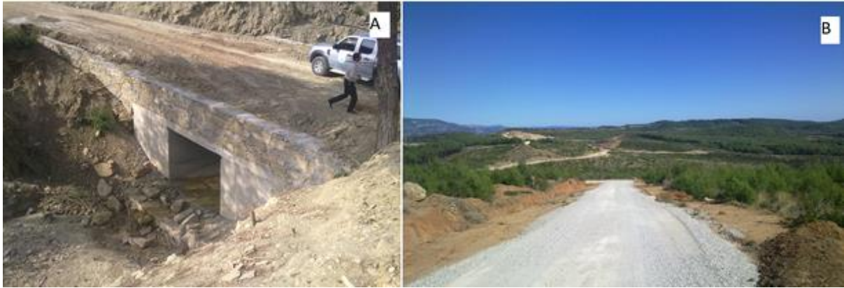
Şekil 8. YDZ yol güzergahı üzerine yapılmış A-bir sanat yapısı, B- üst yapısı
