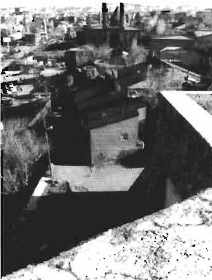
Resim 3 : İç Kaleyi Çifte Minareli Medreseye bağlayan ön duvar üzerindeki yapılaşma
