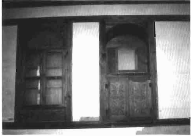
Resim 6 : Zaimođlu Konađı, Oda Duvarında Gönme Dolaplar
