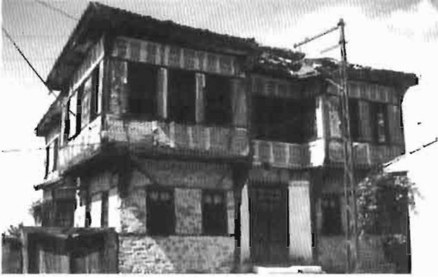
Resim 1 : Zaimoğlu Konağı, Dış Görünüş
