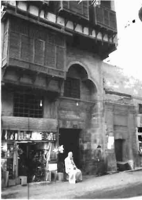
Resim : 5 Kamiliye Medresesi'nin Mevcut Giriş Cephesi
