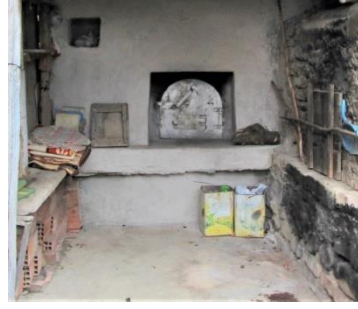
Foto. 84. 7 Numaralı İkiz Fırın ön cephe ayrıntıları (sağ eski fırın, sol yeni fırın)
