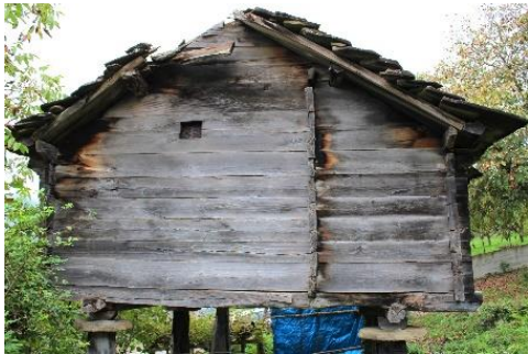
Foto. 16. 1 Numaralı Ambarın doğu cephesi
