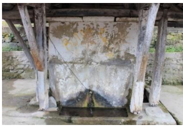
Foto. 97. Otmanlı Çeşmesi batı cephe
