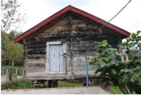
Foto. 30. 3 Numaralı Ambarın ön cephesi
