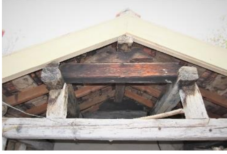
Foto. 83. 7 Numaralı İkiz Fırın çatı ayrıntısı (kanallı birleştirmeler)
