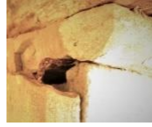
Foto. 103. Otmanlı Çeşmesi taş doku içinde demir kenet
