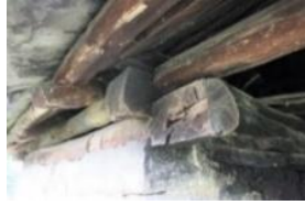
Foto. 75-77. 5 Numaralı İkiz Fırının soldakinin fırın ağzı ile kanallı ahşap birleştirme ayrıntıları
