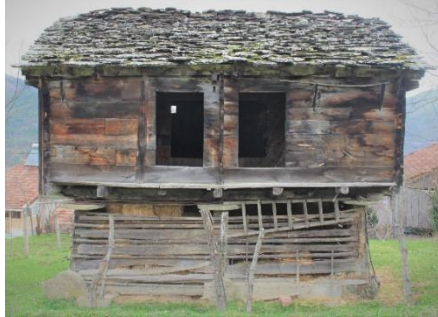
Foto. 42. 5 Numaralı Ambar ön cephesi
