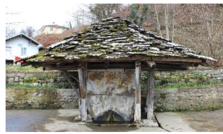
Foto. 96. Otmanlı Çeşmesi batı cephe
