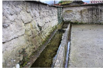
Foto. 89. Köy Meydanında bulunan 1. çeşme
