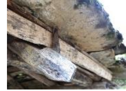
Foto. 112. Otmanlı Çeşmesi saçakta destek kavilası
