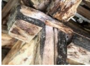
Foto. 104-107. Otmanlı Çeşmesi ahşap kanallı birleştirme ayrıntıları
