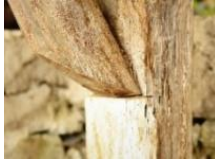
Foto. 108-111. Otmanlı Çeşmesi ahşap kermeli uç birleştirme ayrıntıları
