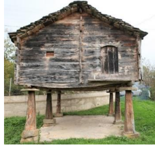
Foto. 40-41. 4 Numaralı Ambarın ön cephesi ve direk başlığı ve taban kirişi kesimi
