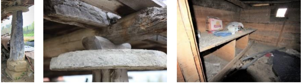
Foto. 26. 2 Numaralı Ambarın direk ayrıntısı (solda)
