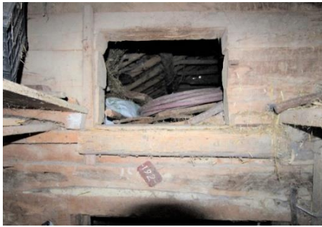
Foto. 5-6. 1 Numaralı Ahır - Ağıl - Samanlık yapısında giriş mekânından samanlığa açılan kapı ve samanlık içine bakış
