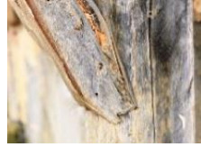
Foto. 108-111. Otmanlı Çeşmesi ahşap kermeli uç birleştirme ayrıntıları
