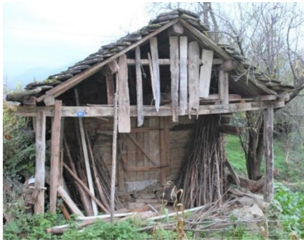
Foto. 9. 1 Numaralı Ahır - Ağıl - Samanlık yapısı ön cephe
