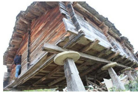
Foto. 25. 2 Numaralı Ambarın üst kat döşeme ve cephe ayrıntıları
