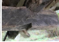
Foto. 108-111. Otmanlı Çeşmesi ahşap kermeli uç birleştirme ayrıntıları
