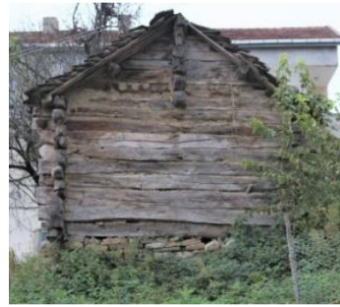
Foto. 10. 1 Numaralı Ahır - Ağıl - Samanlık yapısı arka cephe
