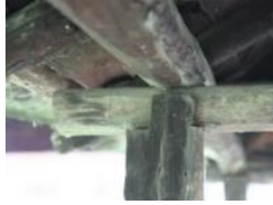
Foto. 75-77. 5 Numaralı İkiz Fırının soldakinin fırın ağzı ile kanallı ahşap birleştirme ayrıntıları
