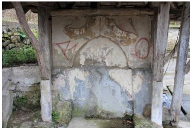
Foto. 94. Otmanlı Çeşmesi kuzey cephe
