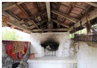
Foto. 69-70. 4 Numaralı Fırın ön cephe ve çatı ayrıntısı ile pişirme hücresi içi
