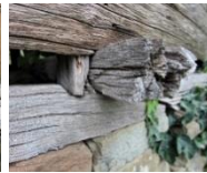
Foto. 64-67. 3 Numaralı Fırın ahşap kanallı birleştirme ayrıntıları ve pişirme hücresi içi
