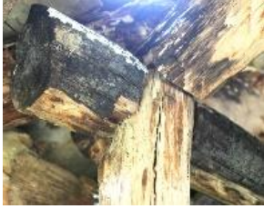
Foto. 104-107. Otmanlı Çeşmesi ahşap kanallı birleştirme ayrıntıları
