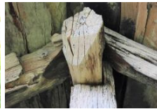
Foto. 64-67. 3 Numaralı Fırın ahşap kanallı birleştirme ayrıntıları ve pişirme hücresi içi
