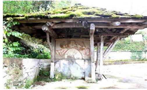
Foto. 93. Otmanlı Çeşmesi kuzey cephe
