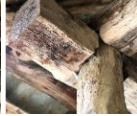
Foto. 104-107. Otmanlı Çeşmesi ahşap kanallı birleştirme ayrıntıları
