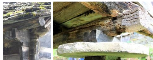
Foto. 17-19. 1 Numaralı Ambarın üst kat içinden ayrıntı (üstte) kurtboğazı geçme ile direk başlığı yastık kiriş ayrıntıları
