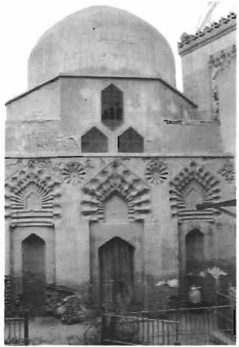
Resim : 6 Abbasi Halifeleri Türbesi'nin Kuzeybatıdan Görünüş
