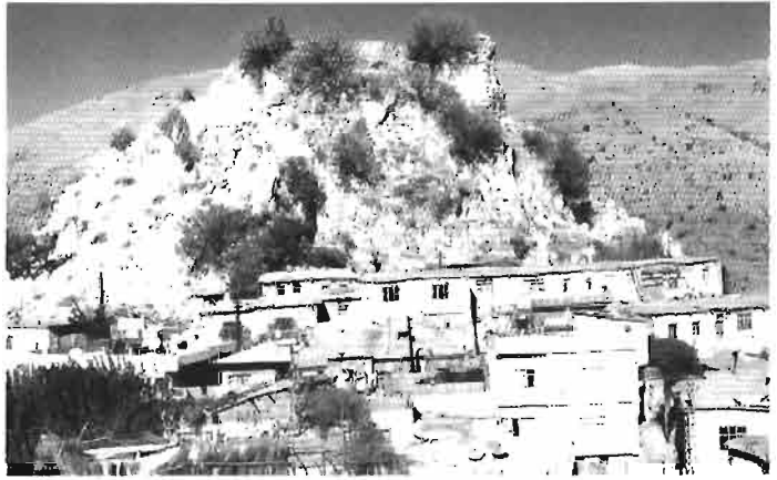
Resim : 2 - Kozluk Kalesinin Güney Batıdan Görünümü
