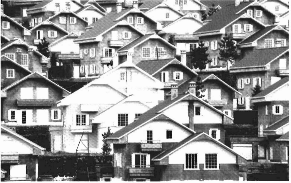
Foto 1 : İstanbul Beykoz Konakları - Çatılar
