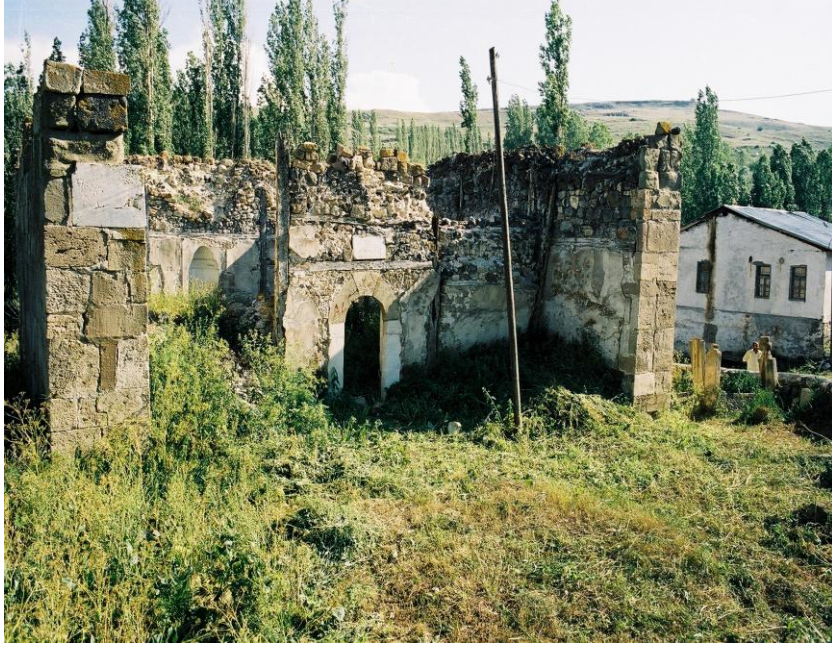
Foto.3- Şarkışla Hardal Köyü Camisi'nin Kuzey Cephesi.
