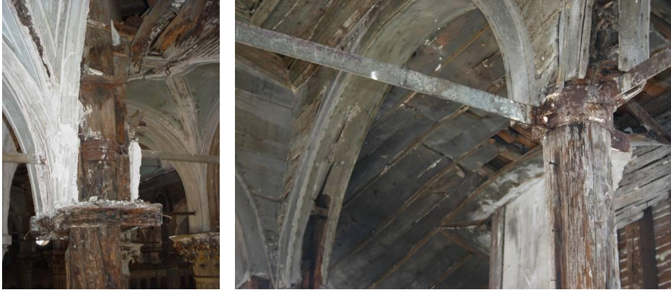
Foto 6 – Taksiarhis (sol) ve Hagia Triada Kiliselerinde (sağ) gergi demiri sütun birleşim detayı
