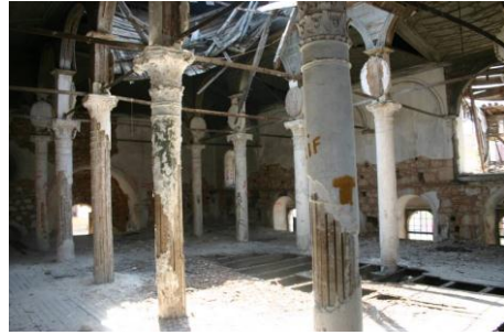
Foto 2- Hagia Triada Kilisesi Ahşap Karkas Loca Beden Duvarı (sol) ve sütunlardan bir detay (sağ)
