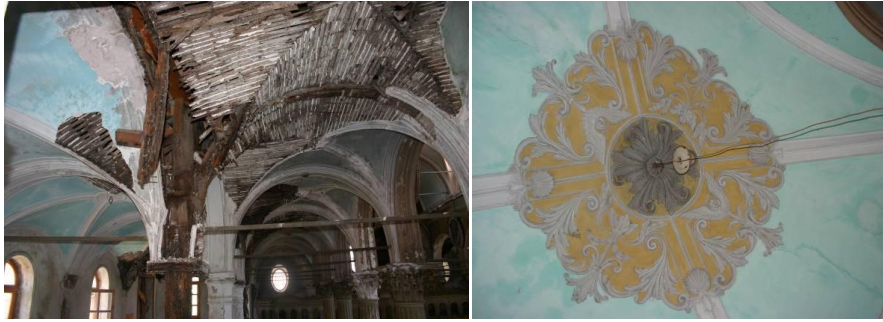
Foto 13– Taksiarhis Kilisesinde loca katının aynalı tonoz tavan örtüsü ve merkezindeki alçı bezemesi
