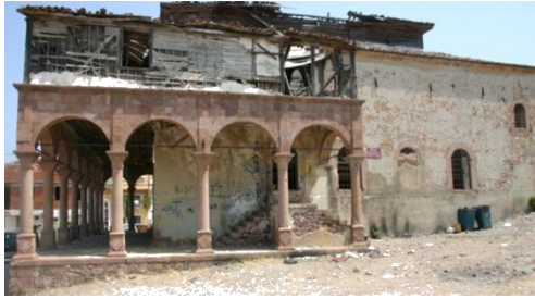
Foto 2- Hagia Triada Kilisesi Ahşap Karkas Loca Beden Duvarı (sol) ve sütunlardan bir detay (sağ)
