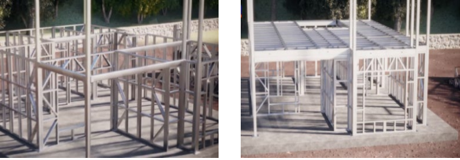
Şekil 19. Döşeme kirişlerinin yerleştirilmesi (Installation of floor beams) (Taşkiran, 2005)
