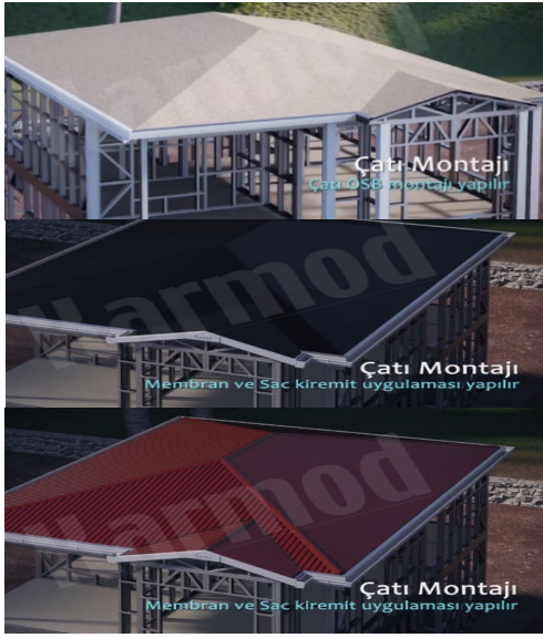
Şekil 30. Çatı iskeleti üzerine OSB, membran ve sac kiremit uygulaması (Application of OSB, membrane and sheet tile on the roof frame) (Karmod Prefabrik Yapı, 2021).
