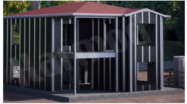
Şekil 34. Nem bariyer üzerine döşenen M profiller (M profiles laid on moisture barrier) (Karmod Prefabrik Yapı, 2021)
