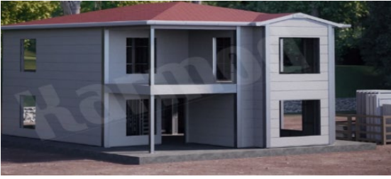
Şekil 37. Kaplama işlemi sonrası genel görünüş (General view after coating process) (Karmod Prefabrik Yapı, 2021)
