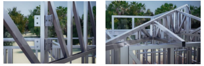
Şekil 26. Çatı makas montajı (Installation of roof truss) (Karmod Prefabrik Yapı, 2021)
