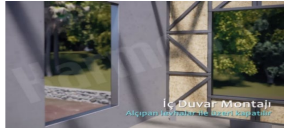
Şekil 40. Duvarların alçıpan levhalar ile kaplanması (Covering the walls with plasterboard sheets) (Karmod Prefabrik Yapı, 2021)
