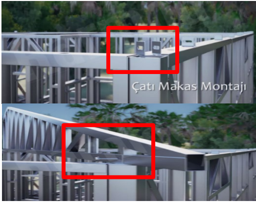
Şekil 25. Çatı makas montajı (Installation of roof truss) (Karmod Prefabrik Yapı, 2021)
