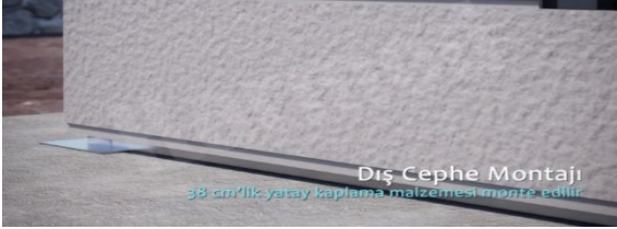
Şekil 36. 38cm'lik yatay kaplama malzemesinin montajı (installation of 38cm horizontal coating material) (Karmod Prefabrik Yapı, 2021)
