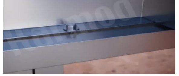
Şekil 20. Döşeme kiriş kapaklarının montajı (Installation of floor beam covers) (Taşkiran, 2005)
