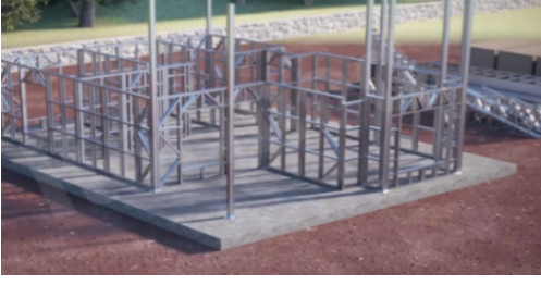
Şekil 18. Ankrajlama işlemi biten zemin kat duvarları (Ground floor walls that have completed the anchoring process) (Taşkiran, 2005)
