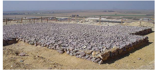
Şekil 12. Blokaj uygulaması (Application of blockage) (Taşkiran, 2005)
