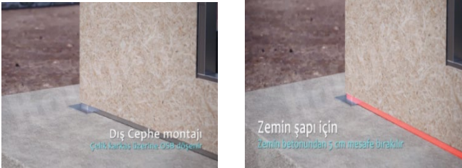
Şekil 31. Dış cephe montajı (Facade installation) (Karmod Prefabrik Yapı, 2021)
