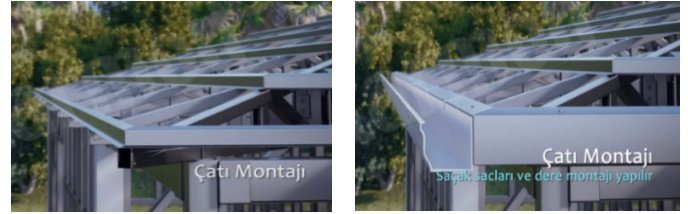
Şekil 28. Saçak sacları ve dere montajı (Eaves sheets and creek installation) (Karmod Prefabrik Yapı, 2021)
