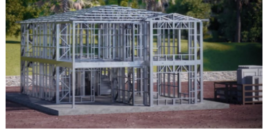
Şekil 29. Tamamlanmış iskelet sistem (Completed skeletal system) (Karmod Prefabrik Yapı, 2021)
