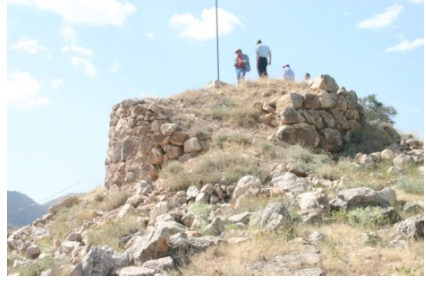
Foto. 21: Çatıksu Gözetleme Kulesi.
