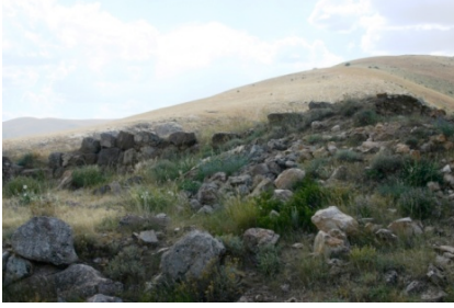
Foto. 20: Çatıksu Gözetleme Kulesi.
