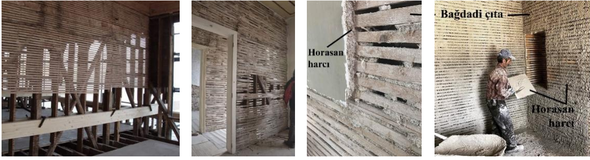
Şekil 7. Bağdadi çitlar ve horasan harcı uygulaması, Bolu Göynük Hükümet Konağı restorasyon projesi
