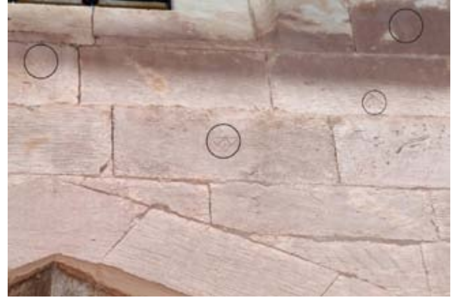
Foto. 6: Caminin güney cephesinde (dış cephe) bulunan taşçı işaretleri
