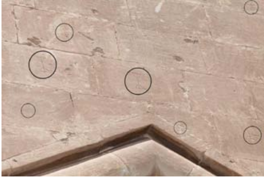
Foto. 4: Selamlığın güney cephesinde (dış cephe) bulunan taşçı işaretleri
