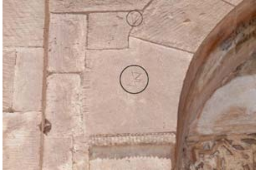
Foto 8: Selamlığın dış cephesinde bulunan taşçı işaretleri
