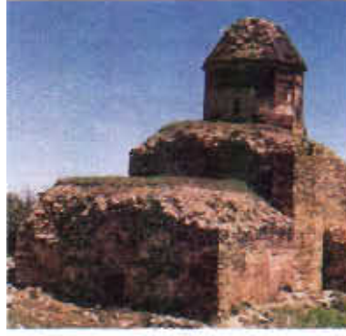
Resim 4. St. Thomas Kilisesi batı cephesi
