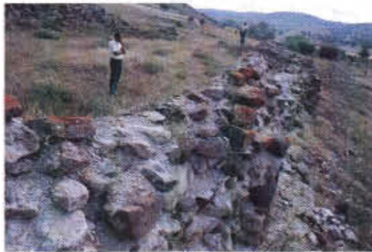
Resim-5: Hoca Hasan Köyü Hanı'nın Güney Duvarı
