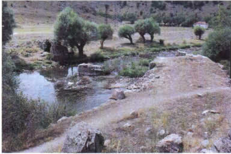
Resim-10: Devrez Köprüsü, Yolun Görünüşü
