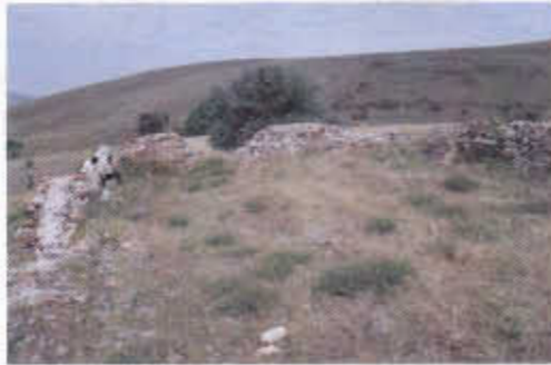
Resim-8: Hoca Hasan Köyü Hanı'nın Kapalı Kısmı ve Duvarları
