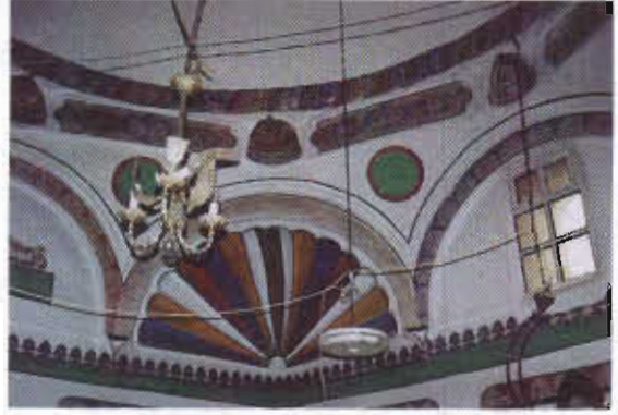
Fotoğraf 12: Piri Baba Türbesi, kubbe eteği ve geçiş sistemi kalem işi süslemeleri.
